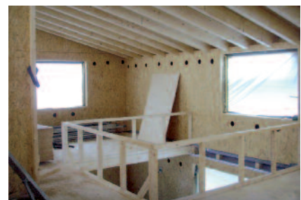
Innenansicht der Galerie im Rohbau
