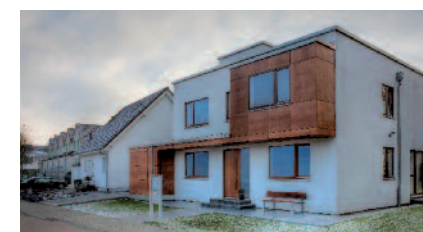
Ansicht von Nordwest mit Perspektive der Straße
